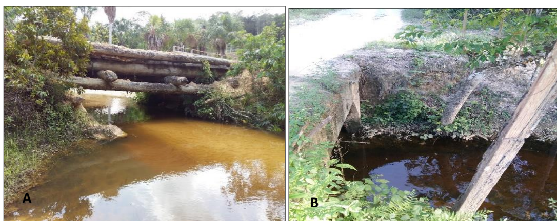
A: Os cursos d'água atravessados por pontes altas ou “pinguelas”, não têm água represada (ramal do Areal); B: Curso d'água, com ponte de concreto (ramal da Água Preta). Fonte: Levantamento de campo, 2019. Fotos: Maria de Fátima da Silva.
