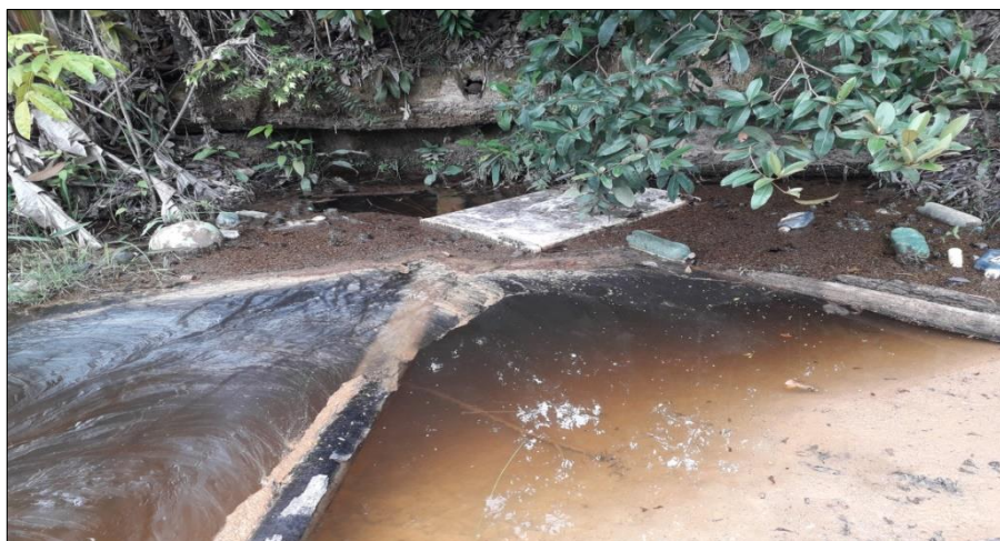
Figura 28 - “Pinguela” obstruindo o fluxo de água e retendo materiais sólidos
