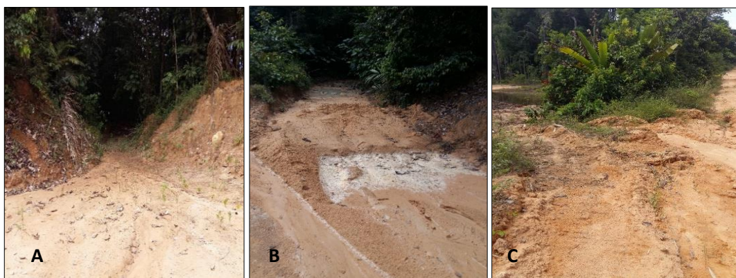
A: Canal de drenagem direcionando a água para o interior da floresta; B: Sedimentos depositados no interior da floresta; C: Canal de drenagem direcionado para o igarapé, onde os sedimentos são depositados. Fonte: Levantamento de campo, 2019. Fotos: Maria de Fátima da Silva.
