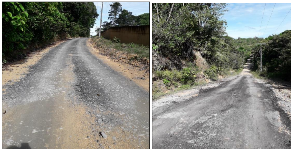
Figura 14 - Manutenção nas declividades do ramal da Água Preta com base rejeito de asfalto.
