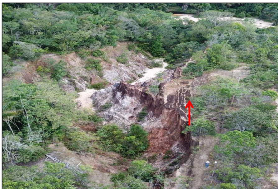
Figura 21 - Vista parcial da voçoroca, que teve seu início durante o ano de 1986. A seta vermelha indica o antigo traçado do ramal Água Preta e ao fundo o igarapé assoreado com o material erodido da voçoroca. Esse ponto é o marco divisor entre ramal da Água Preta e Areal.
