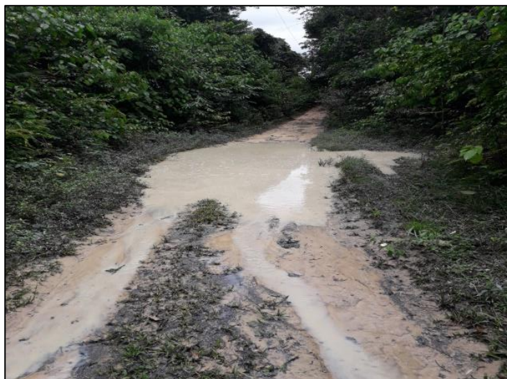
Figura 15 - Formação de pond's, (poças), no ramal da Água Preta/Areal.
