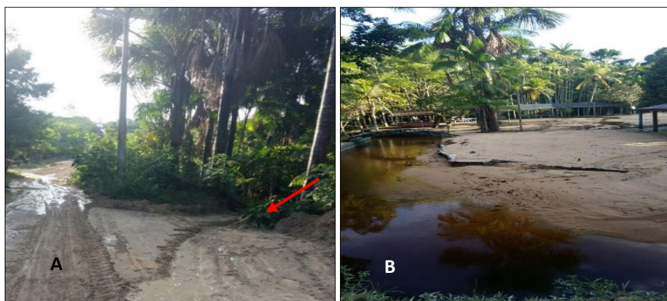
Figura 17 - Erosão e assoreamento ao longo do ramal
