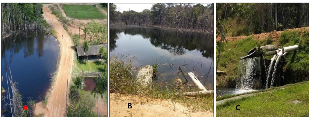
Figura 23 - Represamento dos igarapés no ramal no ramal da Água Preta/Areal
