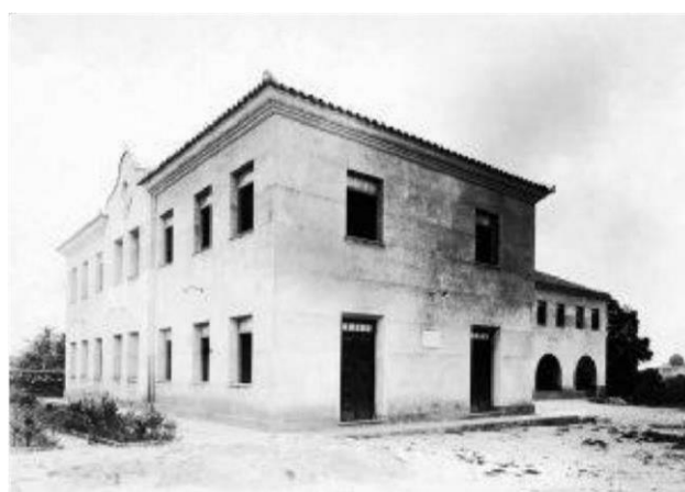
Figura 15: Fachada do Seminário de São José.
