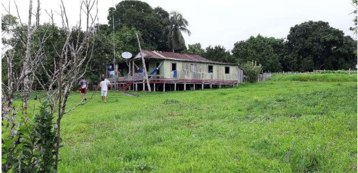
Figura 11 - Habitação de madeira na comunidade São Benedito
