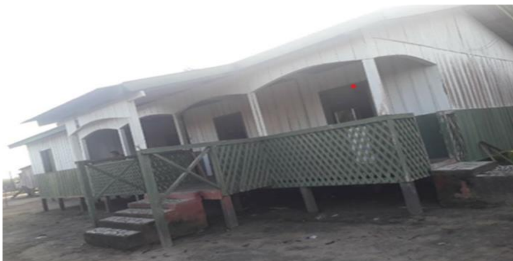
Figura 5 - Escola Rural Dom Bosco/Comunidade do Escondido - Rio Marmelo
