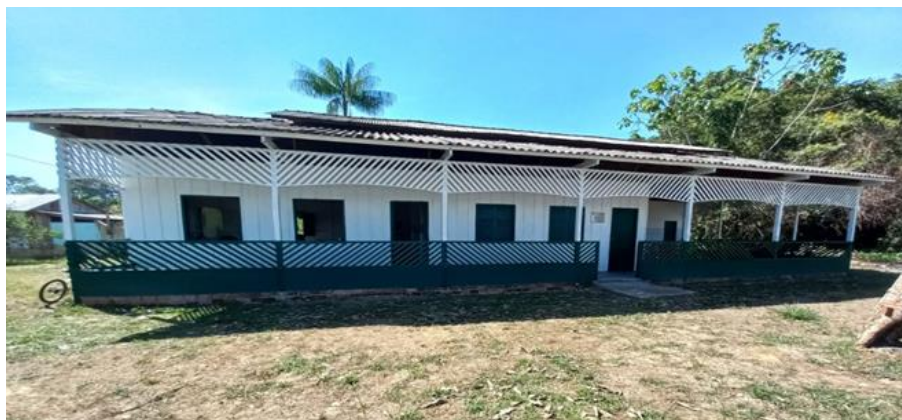
Figura 3 - Escola Rural Bom Samaritano/Comunidade Santa Fé - Rio Madeira
