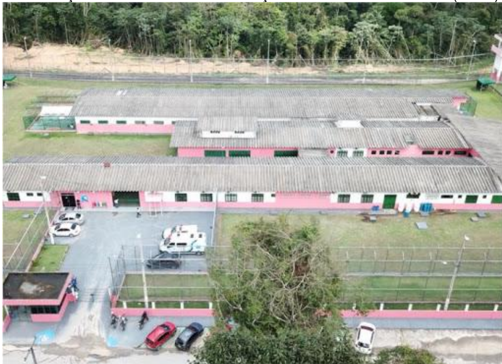
ILUSTRAÇÃO 16 – CENTRO DE DETENÇÃO PROVISÓRIA FEMININO (CDPF)
