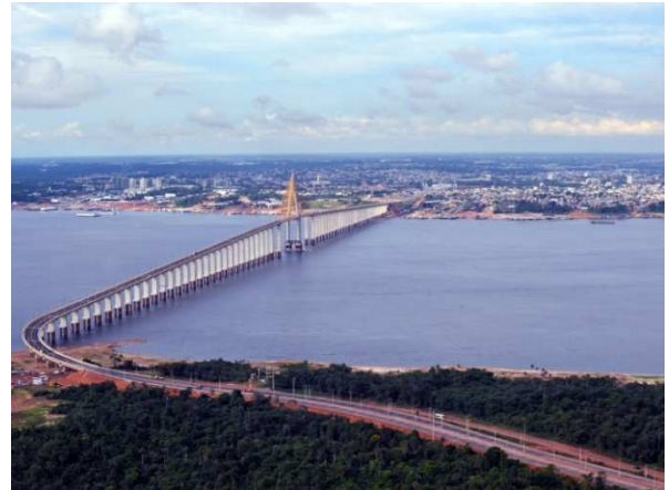
Figura 7 – Ponte sobre o rio Negro
