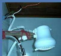
Os chuveiros apresentam internamente um fio condutor que, com a passagem de corrente, aquecem, pelo que chamamos Efeito Joule, e esquentam a água. Os equipamentos elétricos trabalham sempre com potências limite.
