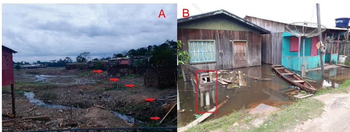
**A** (Quadrante A) – Tubulação sanitária finalizando diretamente do Lago no período de águas baixas; **B** (Quadrante D) – Período de águas altas chegando ao nível do poço, contaminando-o;
