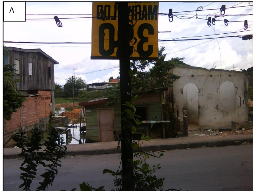
Figura 9 - Demolição das casas pelo PROSAMIM
