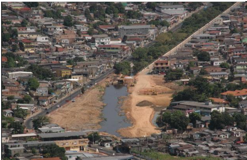
Figura 11 - Obras do PROSAMIM no Igarapé do Franco
