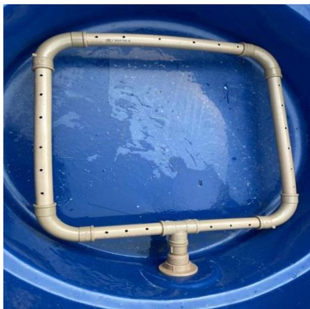
Figura 19 – Tubulação para saída de água
