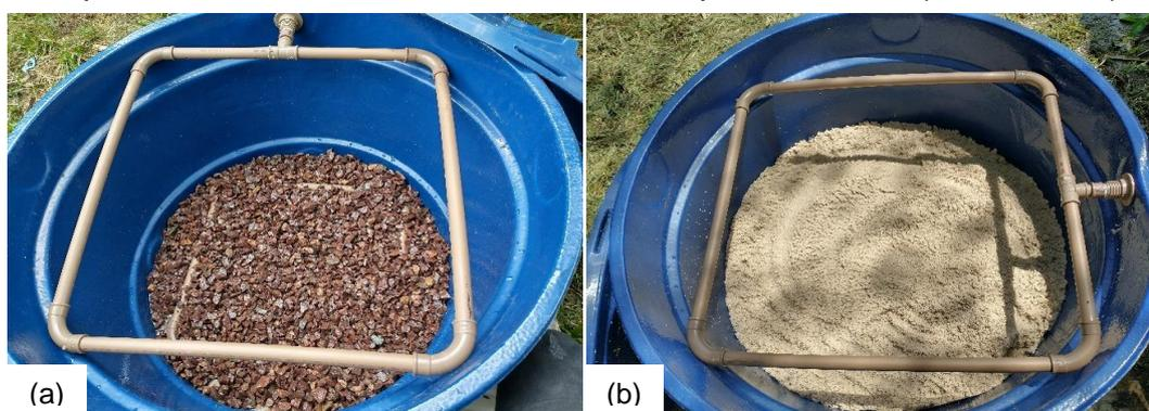
Figura 21 – Meio suporte 20 cm de espessura (a) e meio filtrante 40 cm de espessura (b)
