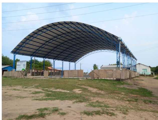
Figura 24. Construção do ginásio da escola
