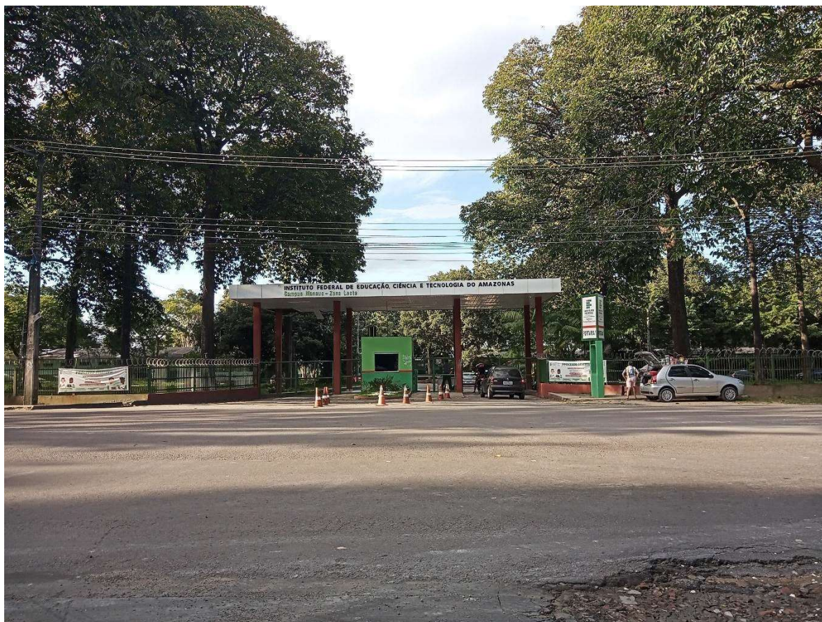
Figura 3 - Entrada Principal do IFAM – CMZL.
